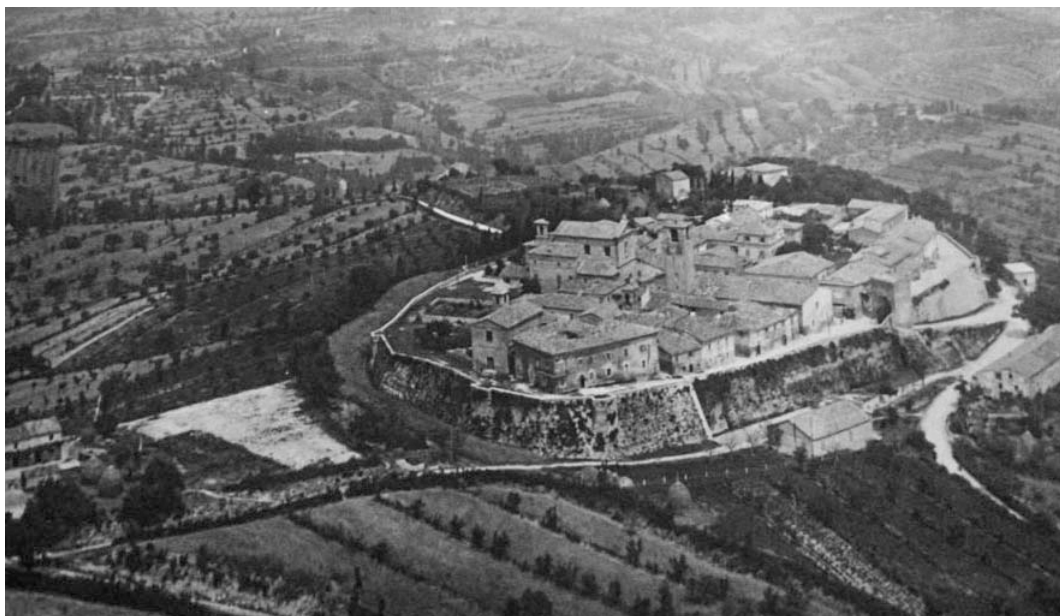
Fig. 4 – Veduta aerea di Novilara nel 1940 (nel lato sud del castello si scorgono il convento dei Gerolimini e la chiesa di San Giuseppe).
