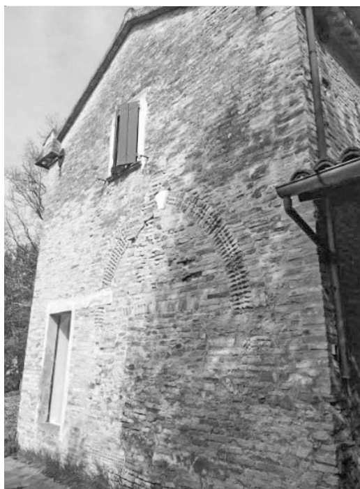
Fig. 9 – Villa Pagani: particolare del portale ogivale.
